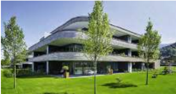
Wohnanlage Zieglergasse | Dornbirn
